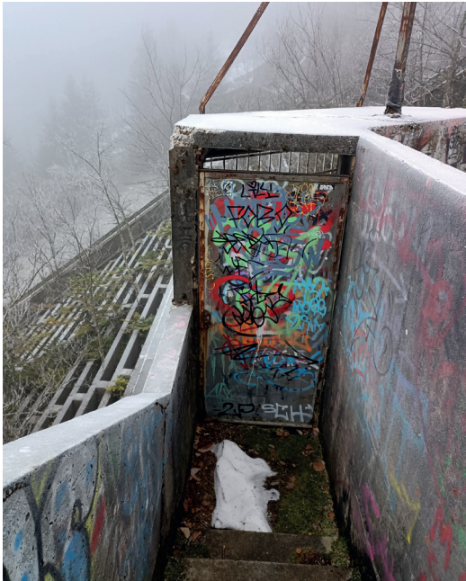
Béton très endommagé par endroit. Granulats visibles, mais pas d'armature apparente. Fissures dans certains murets.
