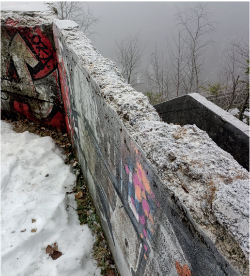
Béton très endommagé par endroit. Granulats visibles, mais pas d'armature apparente. Fissures dans certains murets.
