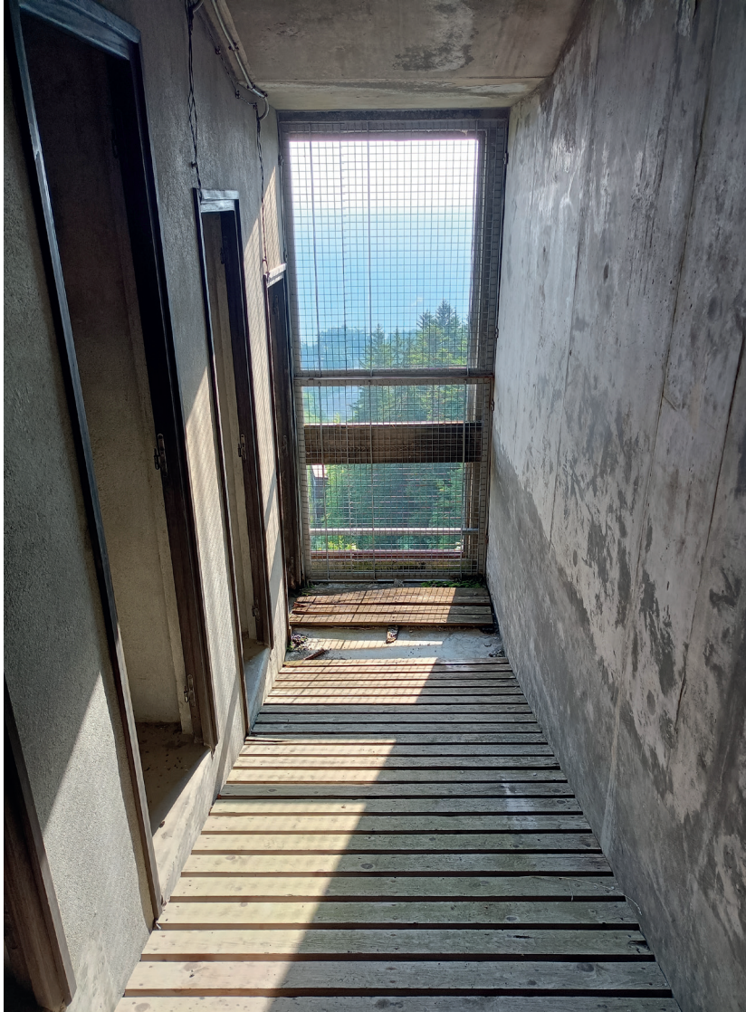
Intérieur du bureau des juges, état correct. Platelage à reprendre en partie basse.
